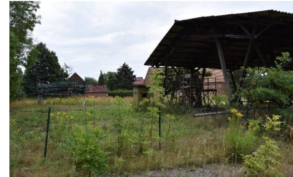
Ehem. Gutshof (OT Quolsdorf)
