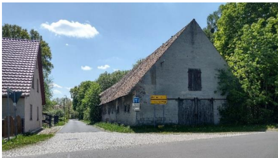
Baufällige Scheune Dorfstraße (OT Trebus)
