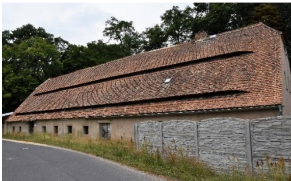
Ehem. Speicher Mühlenweg 5 (OT Quolsdorf)
