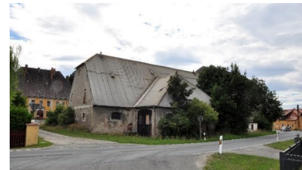
Ruinöse Nebengebäude bei Schloss (OT Spree)
