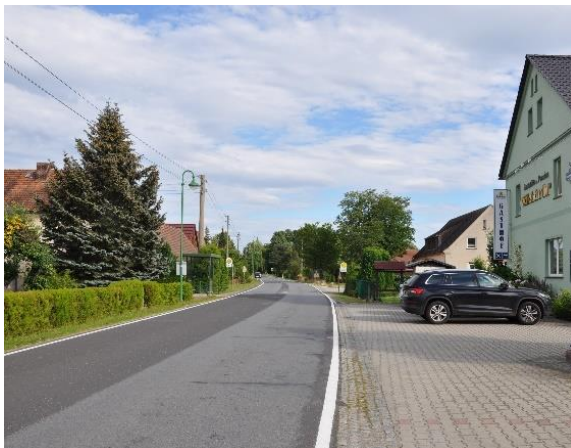
Ortsdurchfahrt Spree ohne Gehweg
