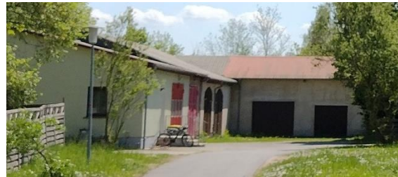
FFW-Gebäude OT Hähnichen
