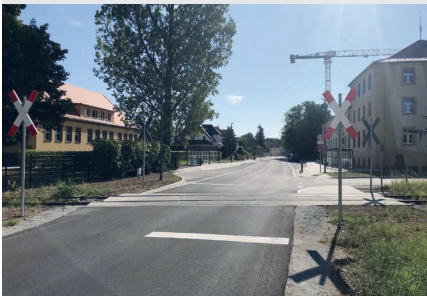
Hier sehen Sie den fertiggestellten Bauabschnitt I der Ushmannsdorfer Str.
