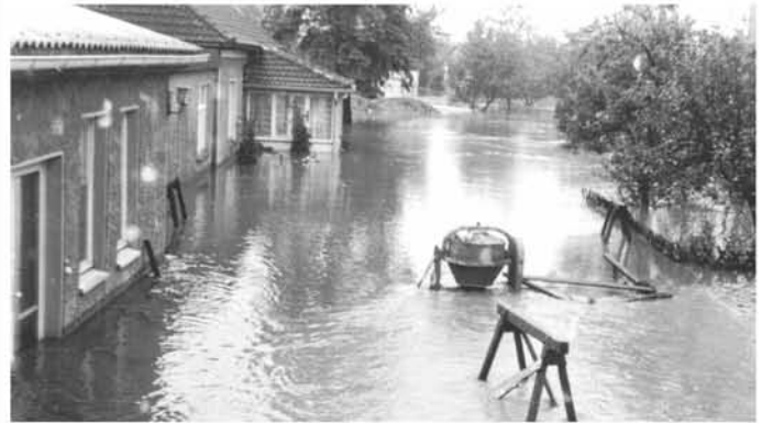
Baustelle im Martinshof
