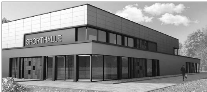
Ansicht Sport- und Mehrzweckhalle
