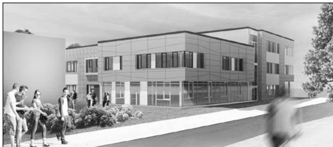
Ansicht Schulgebäude (aus der Innenstadt kommend)
