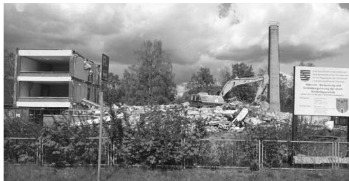
Abriss der ehemaligen Kita in der Martin-Ulrich-Straße
